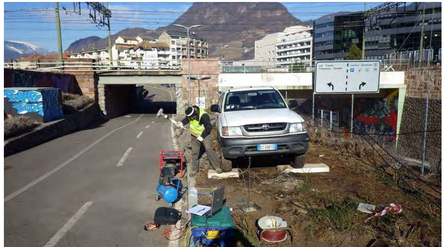
Energizzazione Onde S
