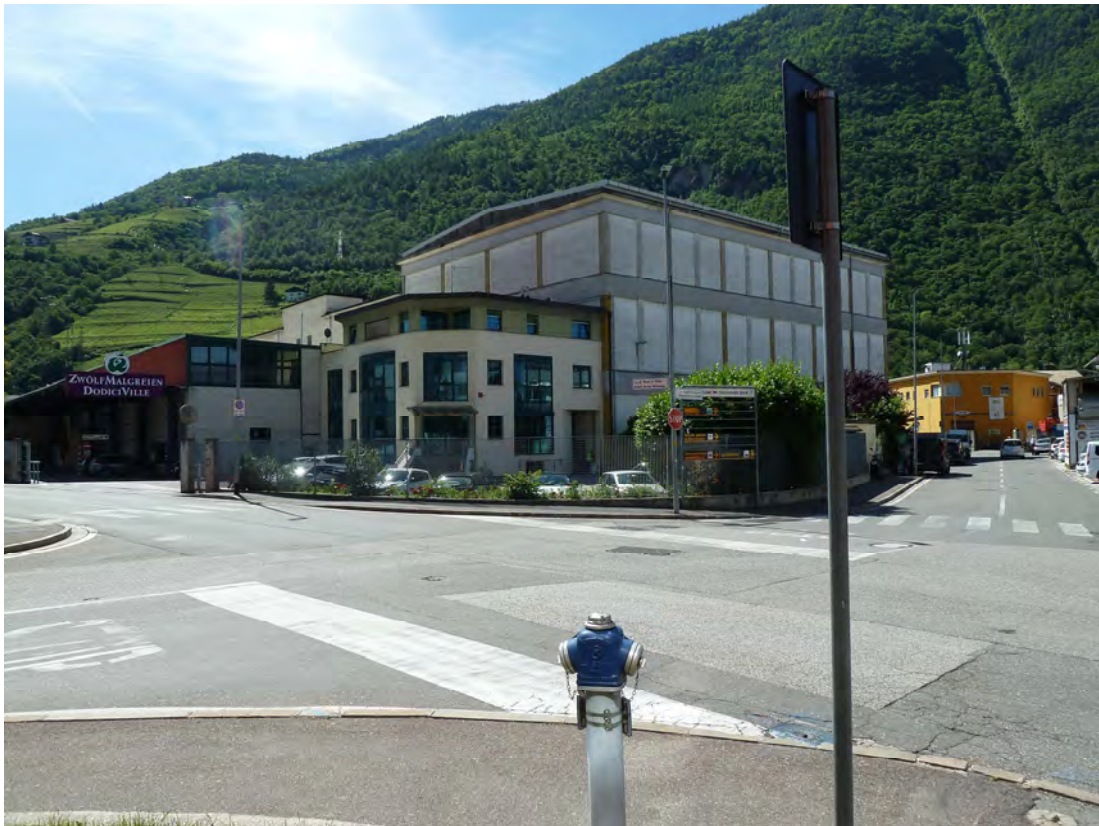
Stato attuale dell'area (Fonte Sopralluogo)
