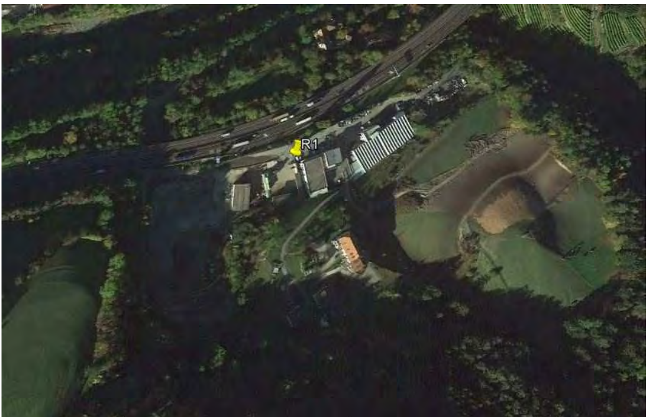
Figura 7: Impianto di recupero della ditta Beton Eisack, nel comune di Chiusa (BZ) in località Gries
