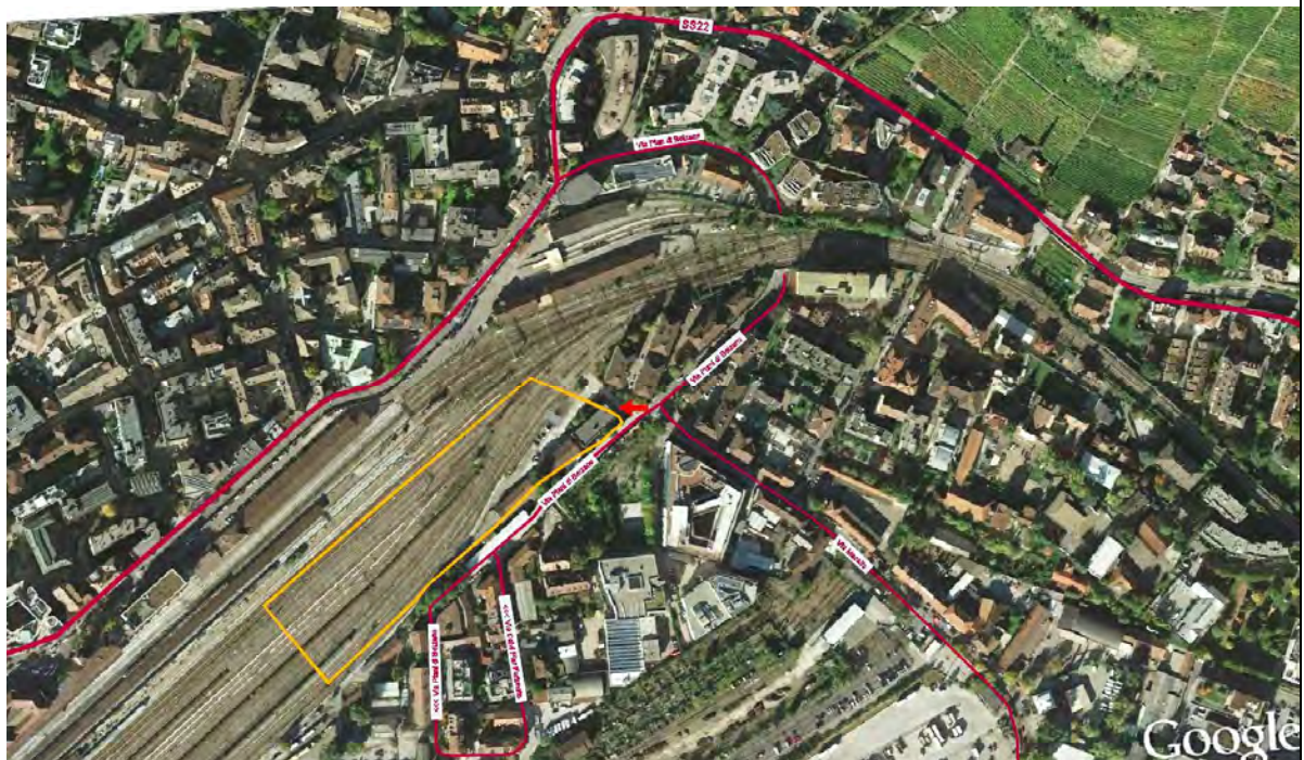
Vista aerea di cantiere CA (Fonte Google Earth)
