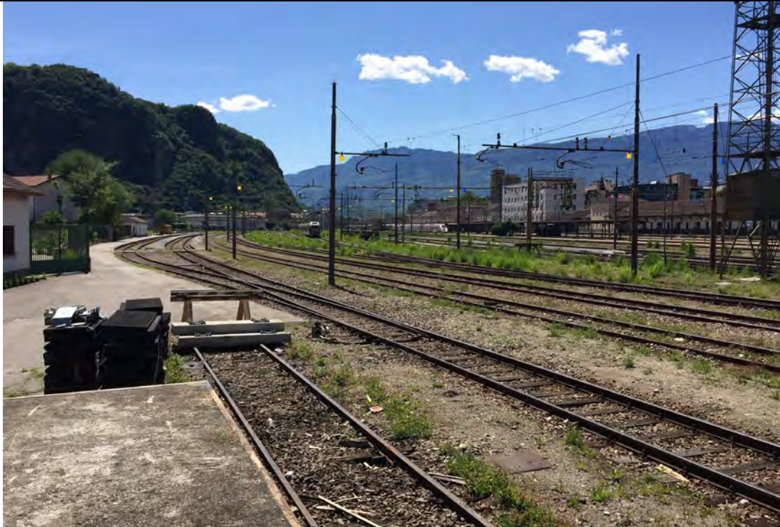
Stato attuale dell'area (Fonte Sopralluogo)
