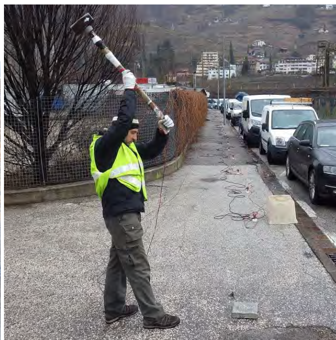
Energizzazione Prova MASW
